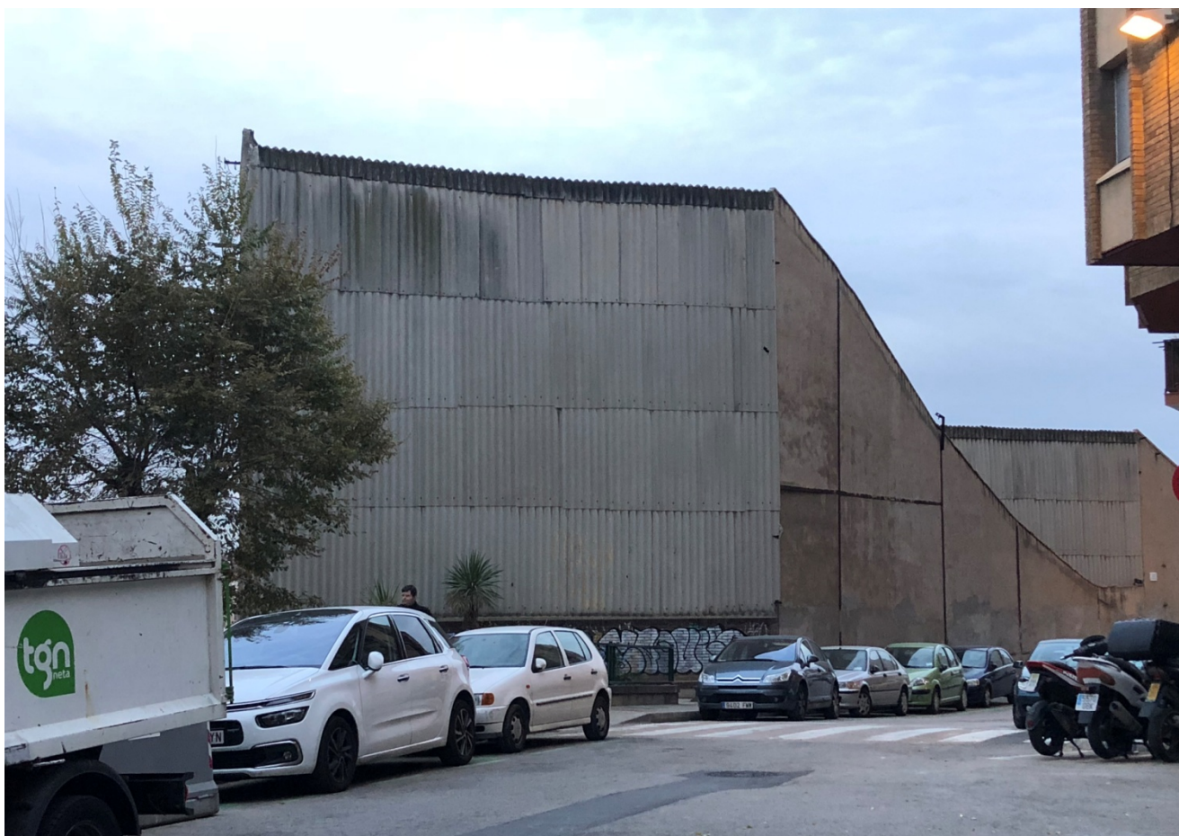
Naves Melero desde la calle superior, Dr Zamenhoff
