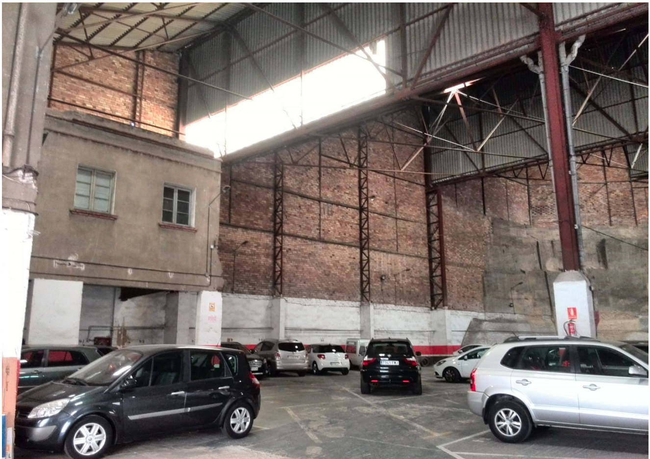
Naves Melero, interior que muestra como la estructura y envolventes de la nave absorbe edificación existente en su interior
